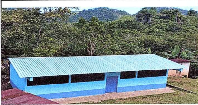
Foto1: modulo 1: Sustitucion de lamina, por lamina troquelada aluzinc y mantenimiento de pintura exterior.
