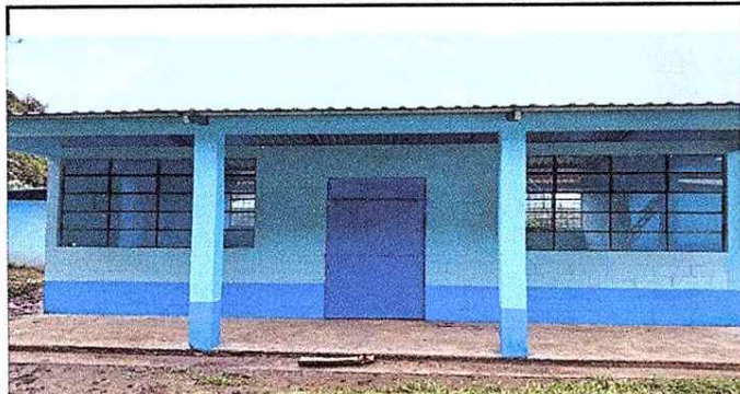
Foto 3: modulo 2: sustitucion de laminas, por laminas troqueladas aluzinc, mantenimiento de puerta y mantenimiento de pintura interior y exterior.
