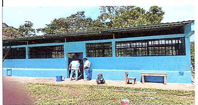
Foto 2: modulo 1: sustitucion de estructura de soporte de madera, por metal , sustitucion de vidrios, mantenimiento de puerta y colocación de balcones de metal.
