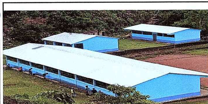
Foto 5: Modulo 3. Sustitucion de laminas, por laminas troquelada aluzinc y mantenimiento de pintura interior y exterior.
