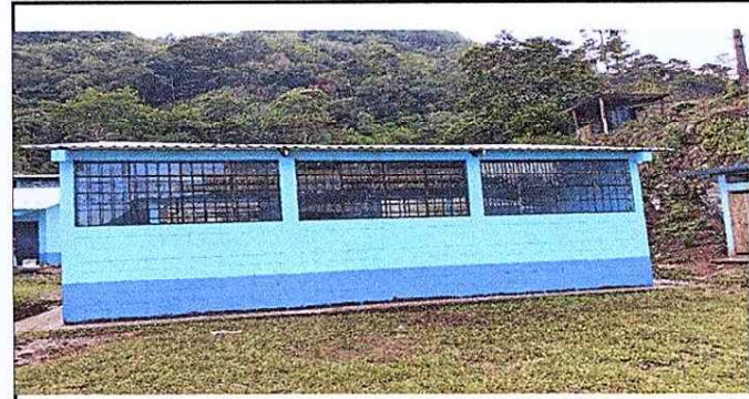
Foto 4: modulo 2. Sustitucion de vidrios, y colocacion de balcones de metal.
